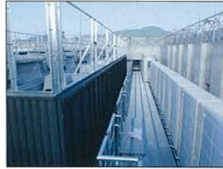
屋上設備機器据付状況
