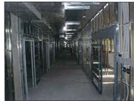
7階内部仕上状況
