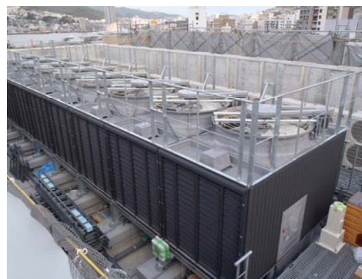
屋上設備機器据付完了状況
