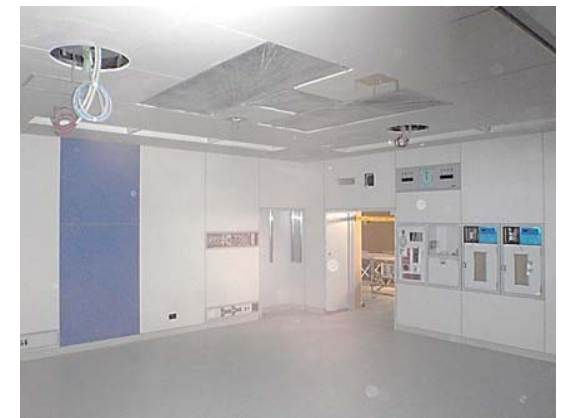
3階手術室 仕上げ状況
