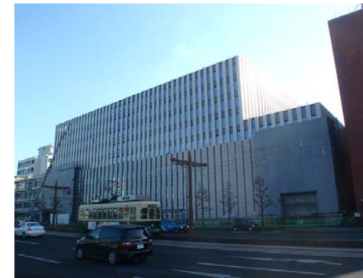
国道側外部足場解体状況
