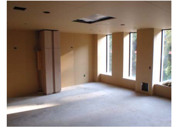
6階病室 仕上げ状況
