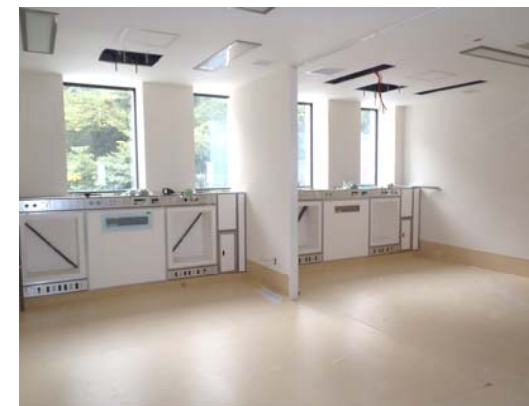
3階ICU室 仕上げ状況
