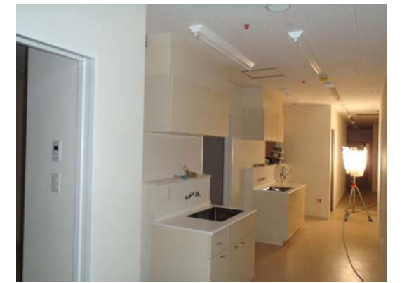
2階スタッフヤード 仕上げ状況
