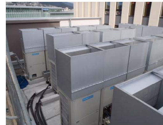
5階屋上 空調室外機据付完了状況
