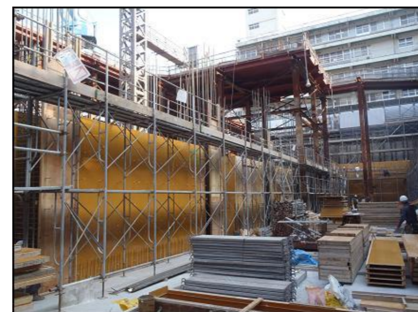
地下2階躯体工事状況
