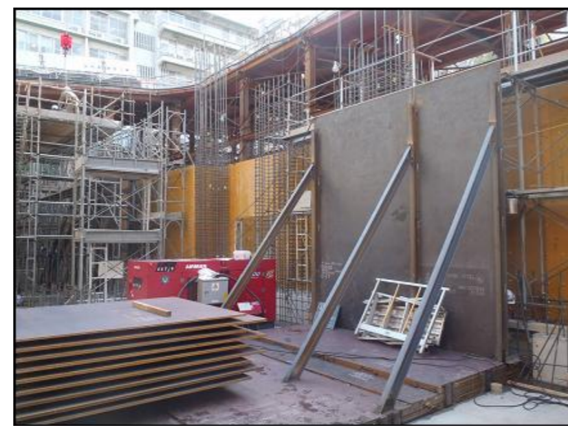
地下2階壁遮蔽鋼板張り工事状況 (リニアック室)
