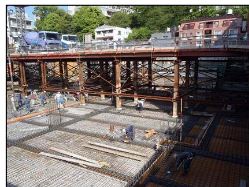
地下1階床コンクリート打設状況
