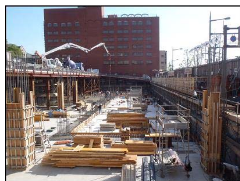
地下1階立上り躯体工事状況
