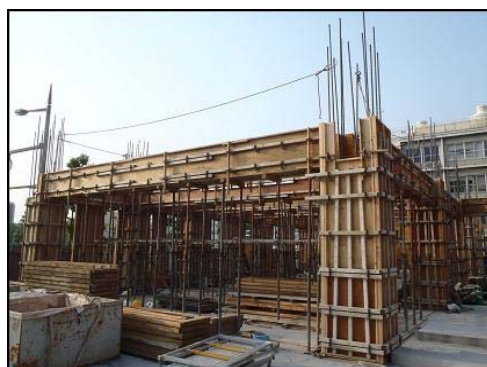
1階立上り躯体工事状況
