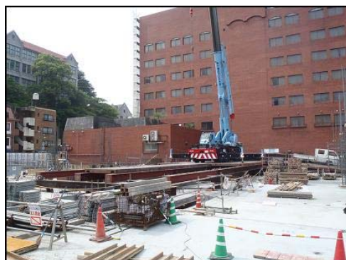
仮設構台解体撤去状況
