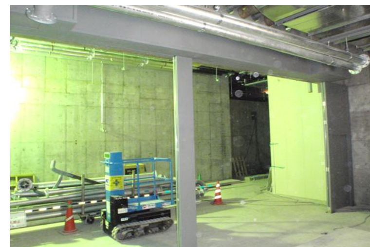
地下2階機械室シャッター取付状況
