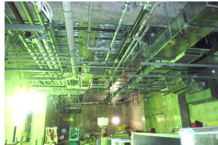
地下2階機械室設備配管工事状況
